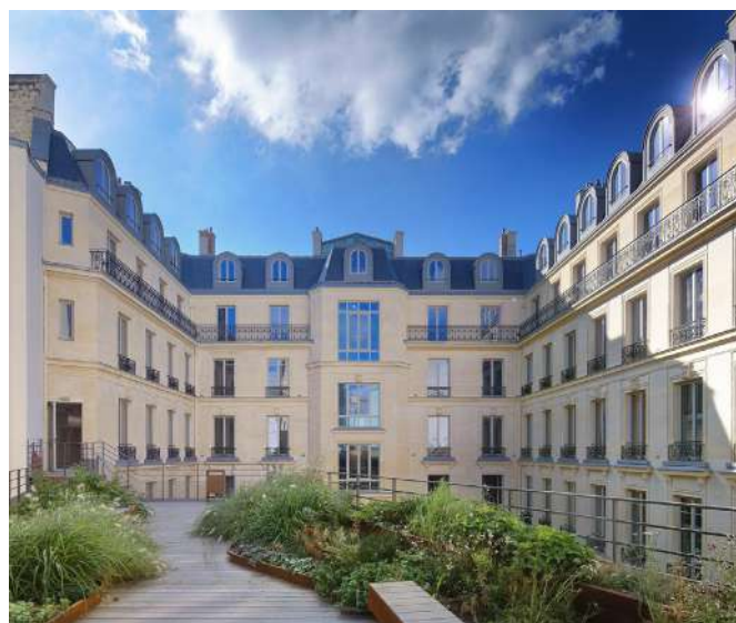
Figure 22 : 6-8 Messine | Paris (75) | BBC Effinergie rénovation 2021 | MO : Generali Real Estate | Architecte : DTACC
