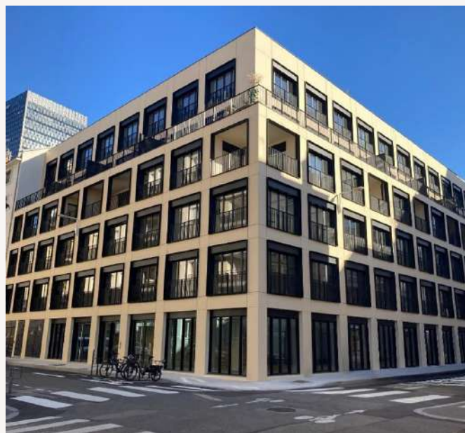
Figure 5 : La Nouvelle Manufacture | Lyon (69) | BBC Effinergie 2017 | MO : Surok | Pietri Architectes
