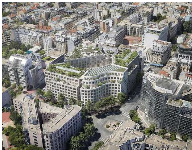
Figure 21 : Level | Levallois Perret (92) | BBC Effinergie rénovation 2024 | MO : Redtree Capital | Architecte : BE Paris - Baumschlager Eberle
