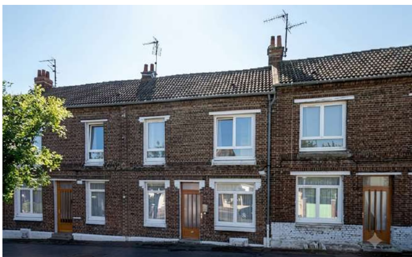
Figure 9 : Cité du 5/12 | Sallaumines (62) | BBC-Effinergie rénovation 2021 | MO : Maisons et Cités
