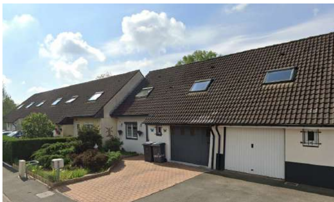
Figure 15 : Résidence Vert Bois | Houplin-Ancoisne (59) | BBC Effinergie Rénovation 2024 | MO : Tisserin Habitat | Architecte : AADA
