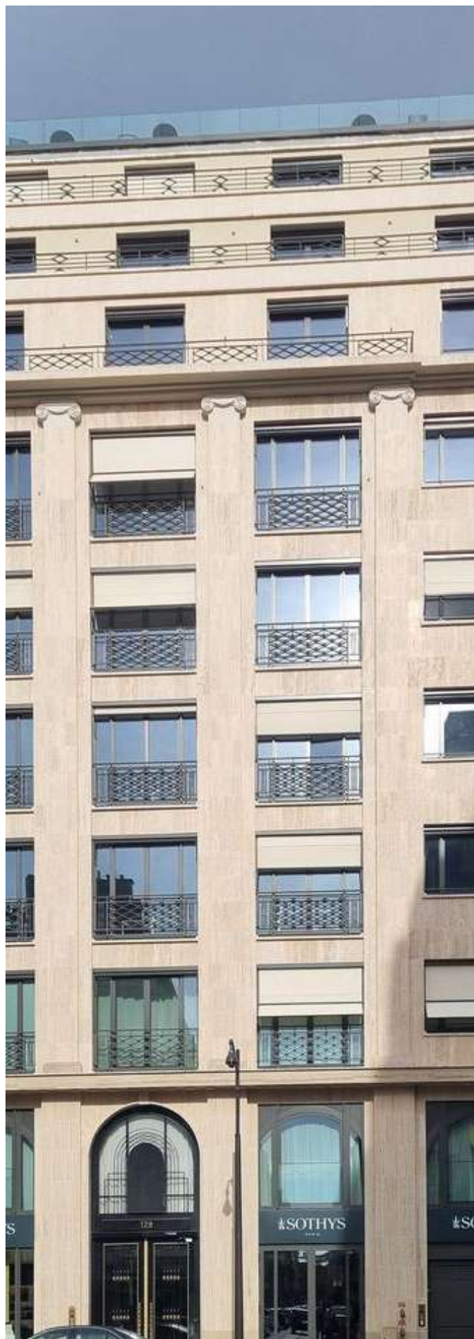
Figure 17 : 128 Faubourg Saint Honoré | Paris (72) | BBC Effinergie Rénovation | MO : SAS Domus Saint Honoré
