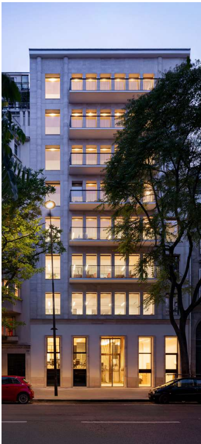
Figure 3 : Bureau 135 Wagram | Paris (75) | BBC Effinergie rénovation 2021 | MO : SARL 135 Wagram | Architecte : Ateliers Quinze Vingts
