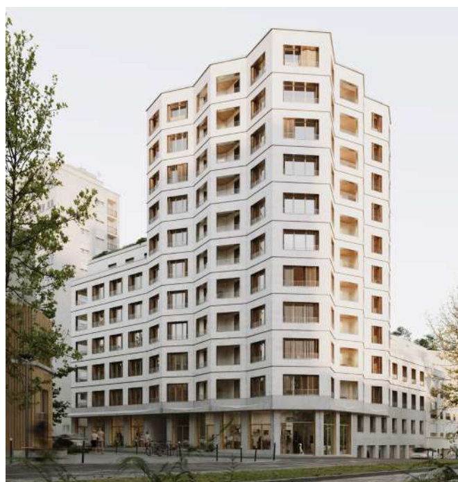
Figure 27 : Zac Chapelle Charbon - Lot F | Effinergie RE2020 | Paris (75) | Première maison Effinergie RE2020 | MO : Elogie-Siemp - Opérateur / Foncière de la Ville de Paris - Organisme de Foncier Solidaire
